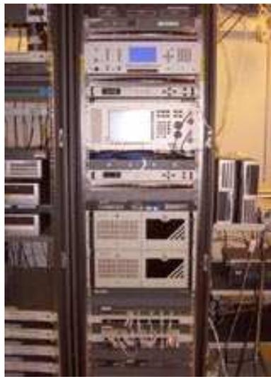
Fig.3: Rack con equipos para encoder y MUX previa a la subida satelital.
